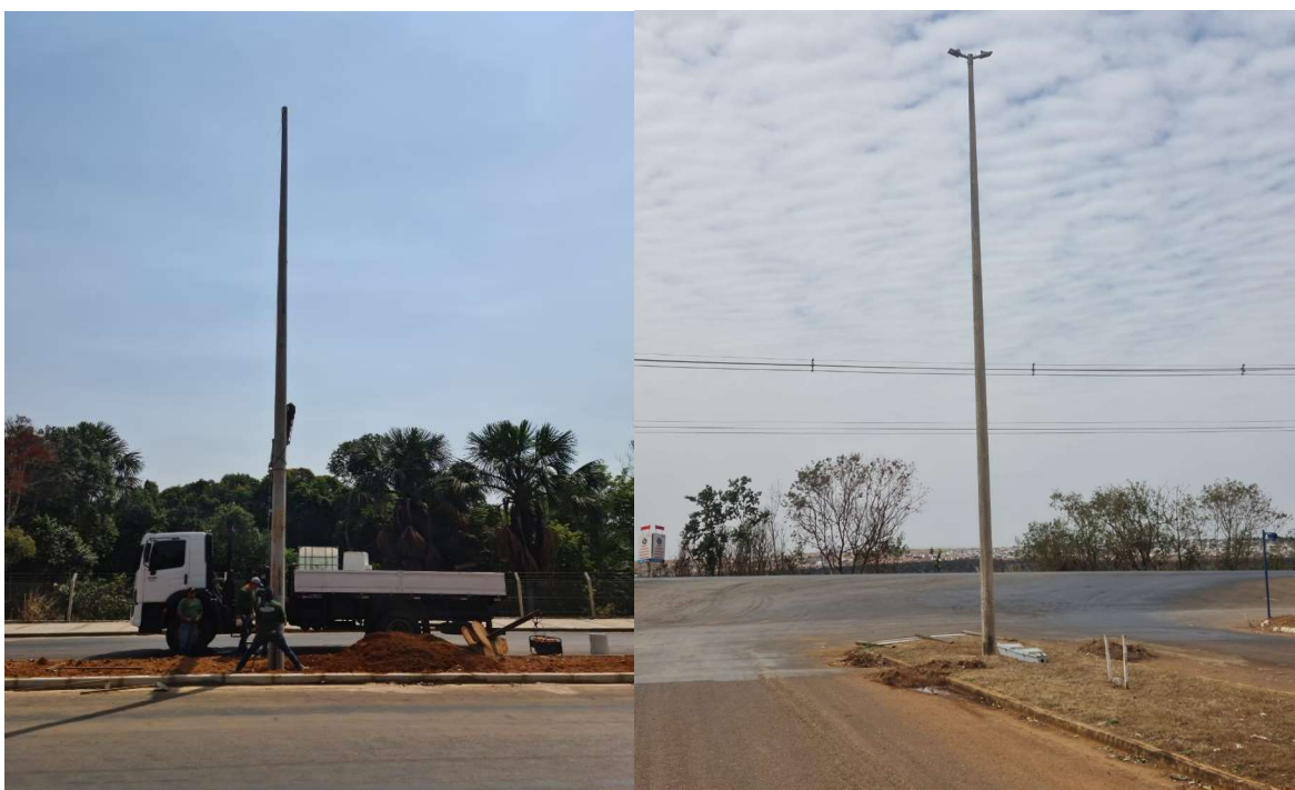
Imagem poste de concreto de 15 mt instalados na cidade de Primavera do Leste
