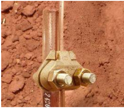
IMAGEM 01 - CONECTOR TIPO GRAMPO (ORÇADO).
