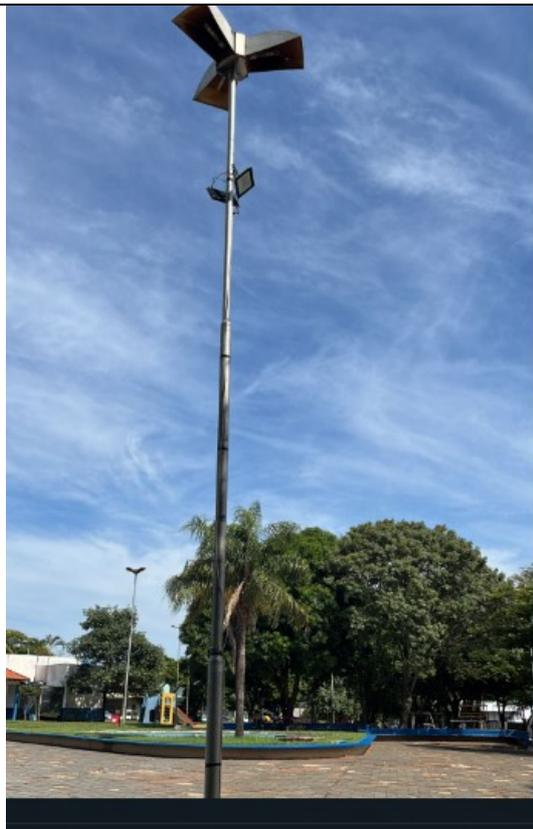
Foto 7 - Podemos verificar a adaptação feita nos postes de iluminação da praça com refletores de LED.
